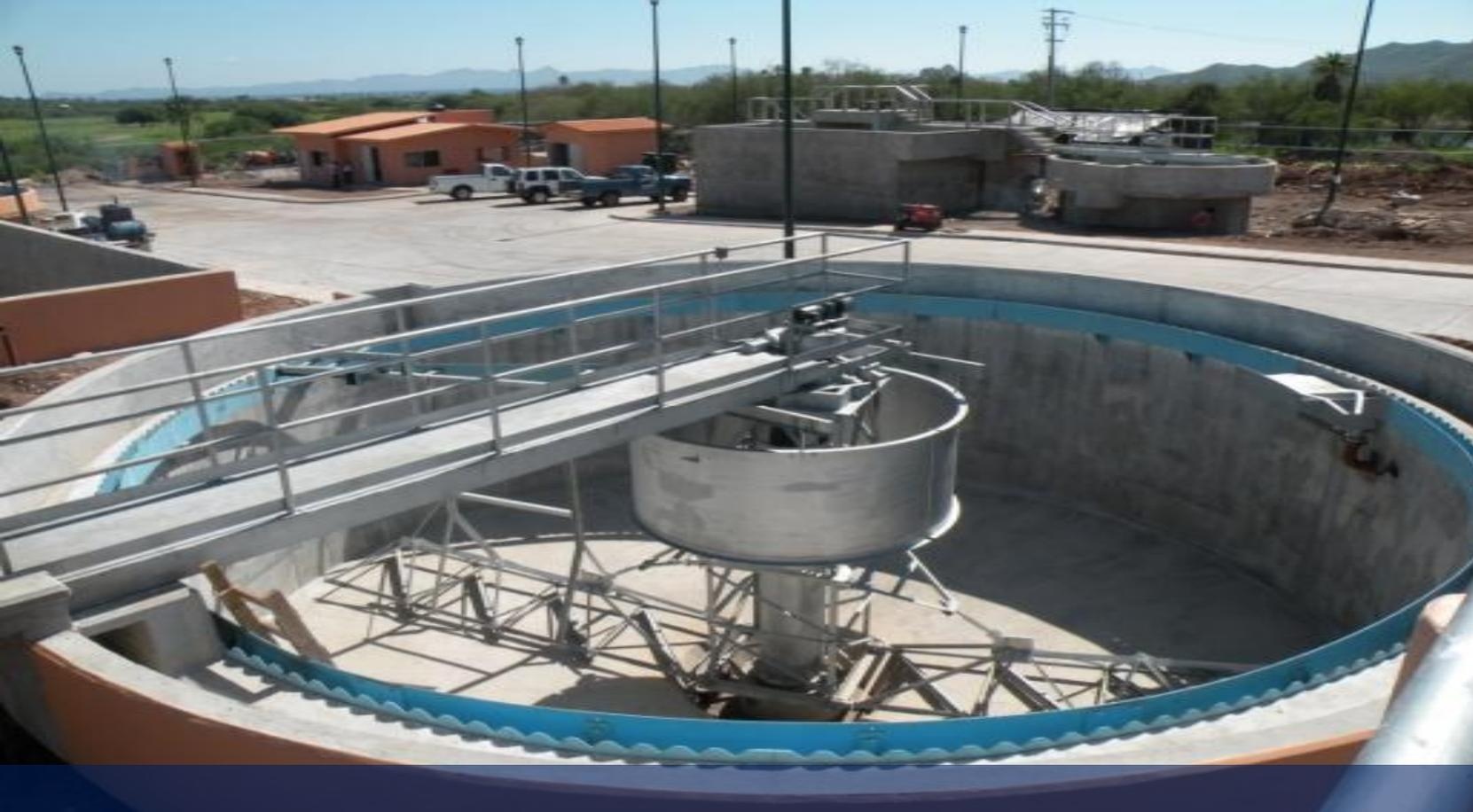
FUNCIONAMIENTO = **LODOS ACTIVADOS** / GASTO DE DISEÑO = **30 lt/seg** / SE COLOCARON **773 m<sup>3</sup>** DE CONCRETO Y **26 Ton** DE ACERO
